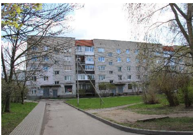
Фотография 3. Подъездные пути, прилегающая территория
