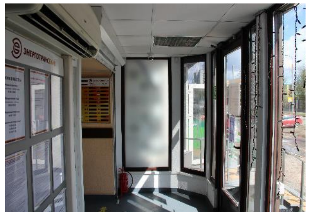
Фотография 12. Фрагменты внутренних помещений объекта оценки
