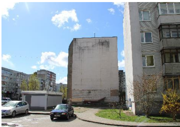
Фотография 2. Подъездные пути, прилегающая территория
