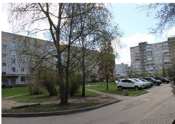
Фотография 4. Подъездные пути, прилегающая территория
