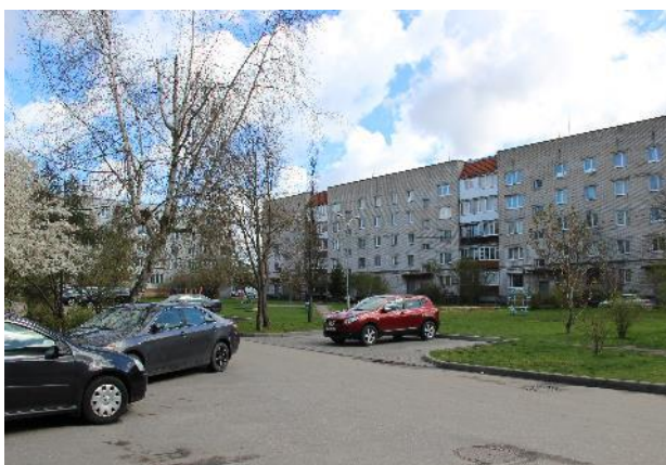
Фотография 5. Подъездные пути, прилегающая территория
