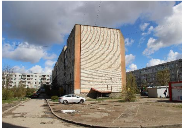
Фотография 7. Фасад здания, в котором расположен объект оценки
