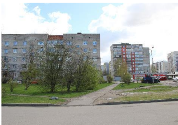
Фотография 6. Подъездные пути, прилегающая территория
