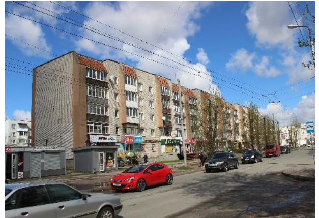
Фотография 8. Фасад здания, в котором расположен объект оценки
